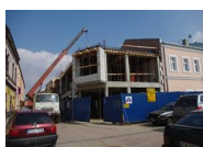
Rys.11 Transport metalowych stempli przy pomocy dźwigu samojezdnego.
