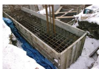
Rys.3 04.01.2011 - stopa fundamentowa gotowa do zabetonowania.
