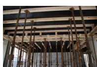
Rys.6 21.02.2011 - strop nad parterem; szalunek ze sklejek na konstrukcji drewnianej, podpartej metalowymi stemplami.
