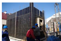
Rys.8 01.03.2011 - ściany klatki schodowej; zbrojenie żelbetowej ściany w szalunku systemowym HUNNEBECK.
