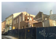
Rys.1 Kamienica przy ul. Cerkiewnej 4 w trakcie rozbiŃrki.
