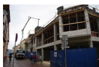
Rys.12 Pompogruszka podczas betonowania słupów drugiego piętra.
