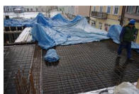
Rys.7 23.02.2011 - zbrojenie stropu nad parterem, czyszczone stropu zabezpieczona przed opadami śniegu.
